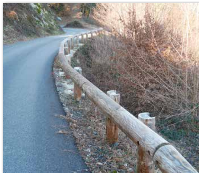
Mise en place de nouvelles barrières de protection à La Combaz et à Saint Thomas
