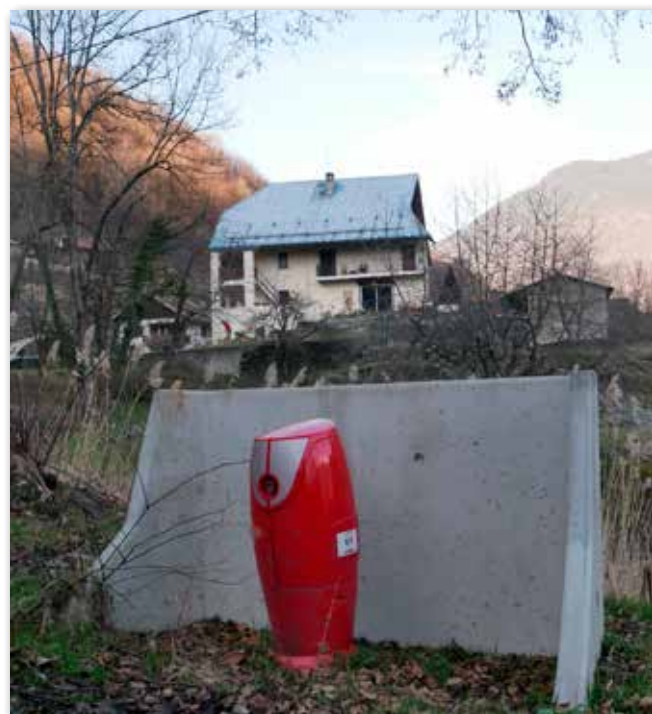
Déplacement d'un poteau incendie à La Combaz
