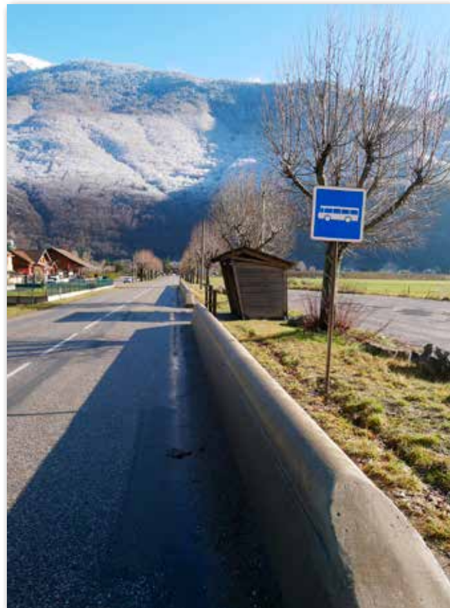
Aménagement dans la Plaine - abribus et muret de protection
